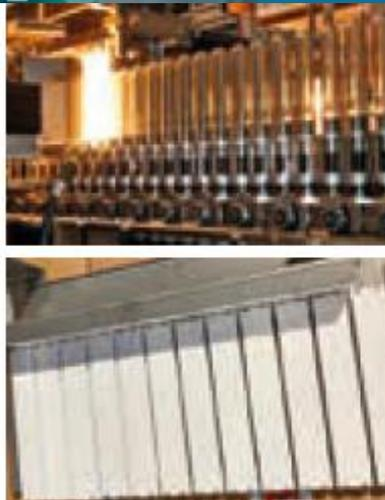
Nuove caldaie ad alto rendimento per la palazzina uffici e spogliatoi. Si integrano con un nuovo sistema di interfaccia automatico che gestisce sia le caldaie che la pompa di calore secondo logiche legate ai sistemi di cogenerazione di stabilimento per l'ottimizzazione dei flussi energetici.
