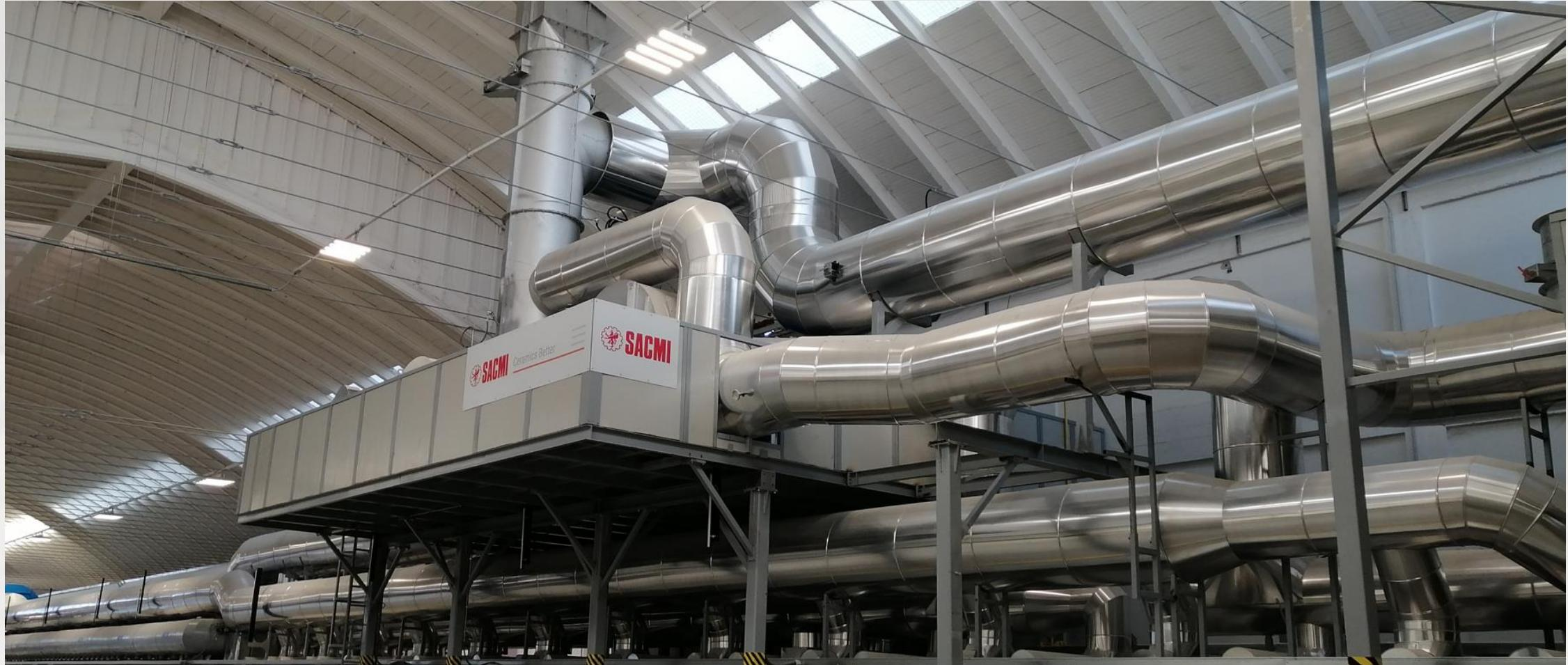
**Tutto il calore dei fumi del forno viene recuperato e utilizzato nelle successive fasi di lavorazione**
